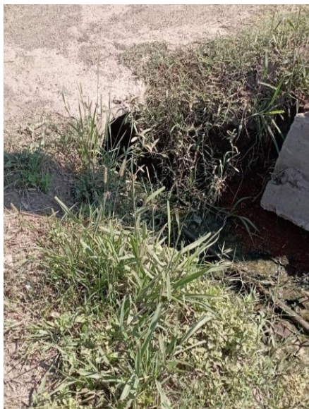
Figura 14 - Estado de alcantarillas (Fuente: Elaboración propia)
