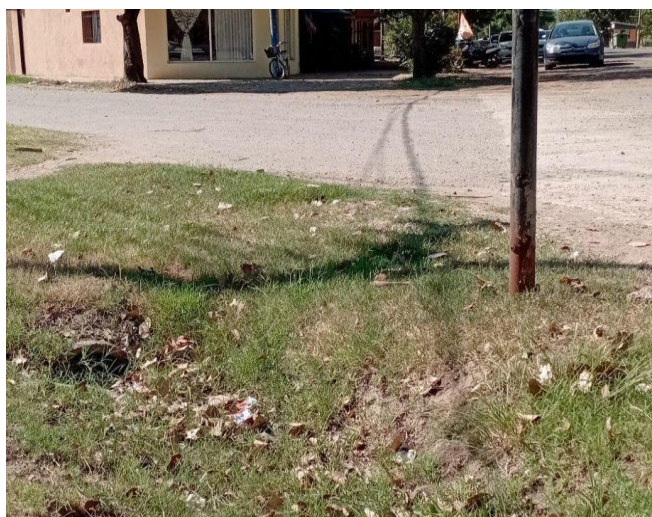
Figura 15 - Estado de alcantarillas (Fuente: Elaboración propia)
