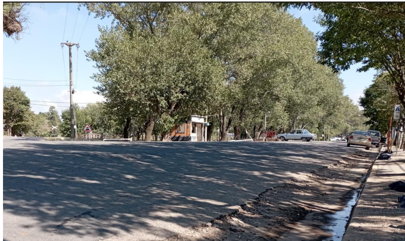
Figura 16 - Estado cordón cuneta (Fuente: Elaboración propia)
