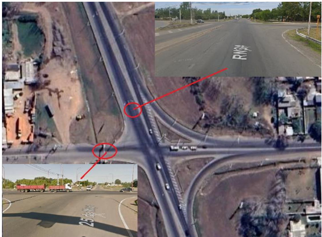
Figura 55 – Situación actual (Fuente: Google Maps)
