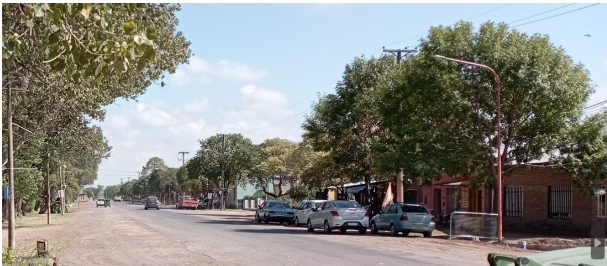
Figura 18 - Tendidos eléctricos y luminarias (Fuente: Elaboración propia)
