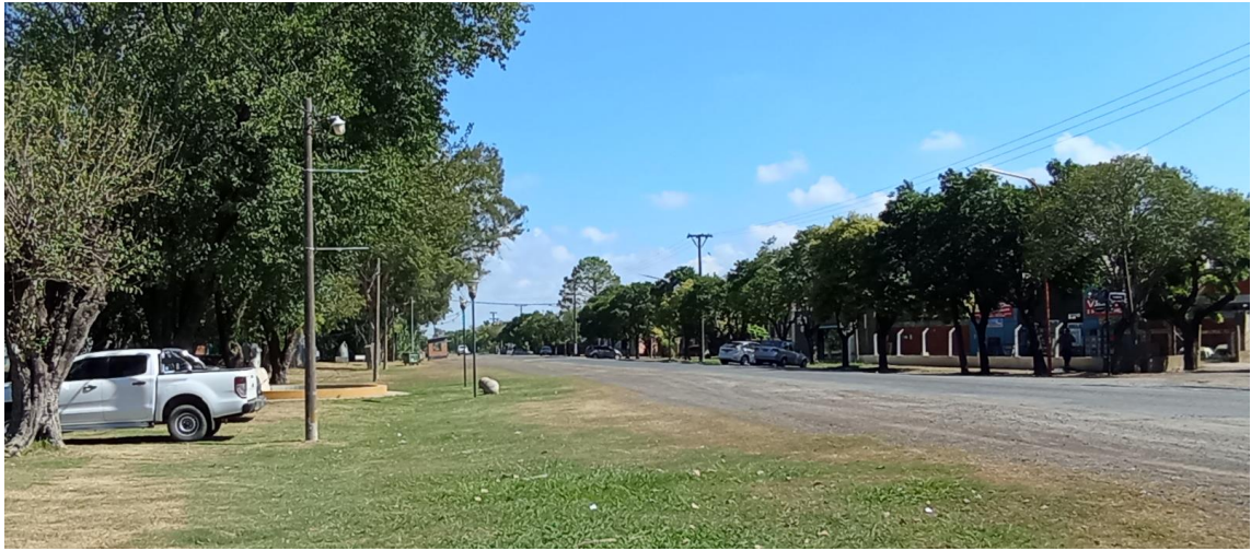
Figura 17 - Tendidos eléctricos (Fuente: Elaboración propia)
