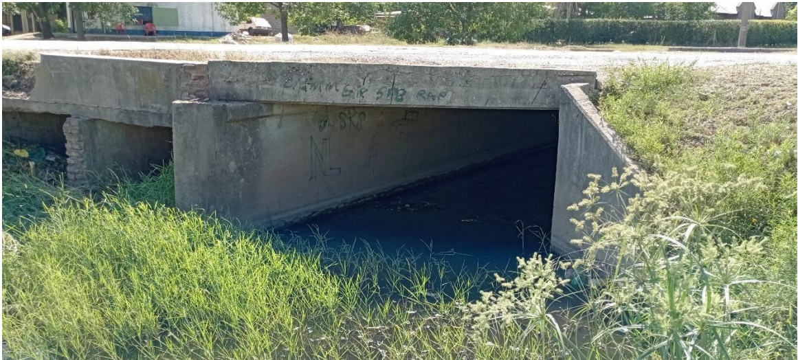
Figura 20 - Alcantarilla Canal Urquiza en el cruce con Av. Del Rosario (Fuente: Elaboración propia)
