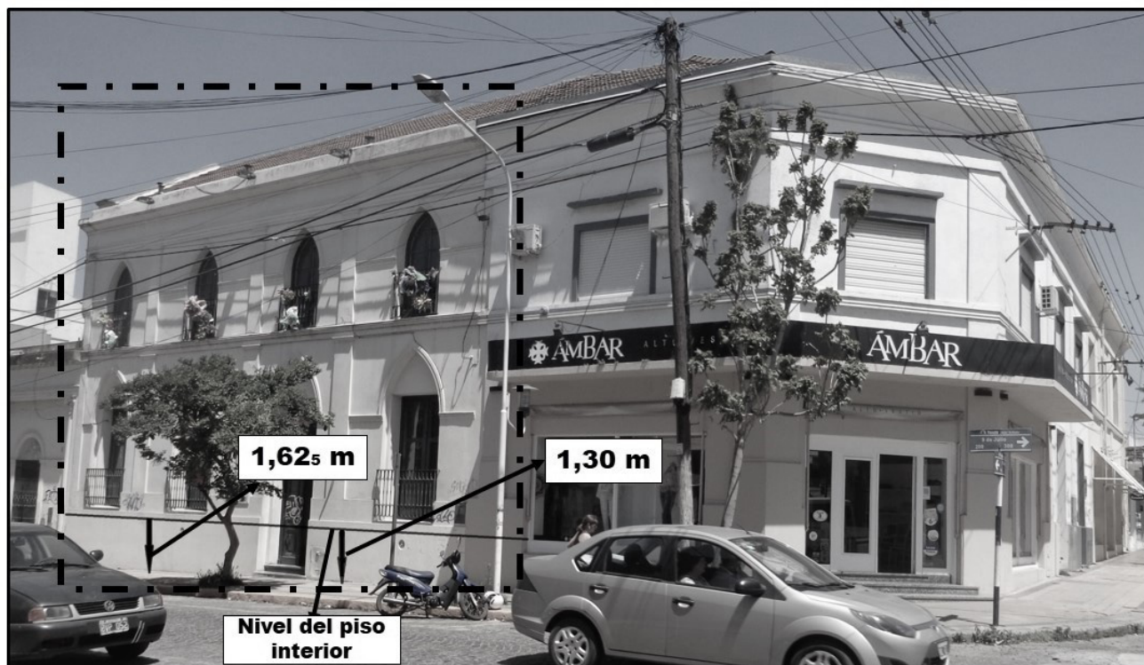
Figura 3. Foto de la actual casa de Juan Fugl donde se puede observar el recuadro punteado la estructura original de la casa, con la línea negra marcando el piso de madera Pino Tea y como éste se distancia de la vereda que respeta la pendiente natural del terreno. Está pendiente desagua en el arroyo del Fuerte (actualmente entubado)
