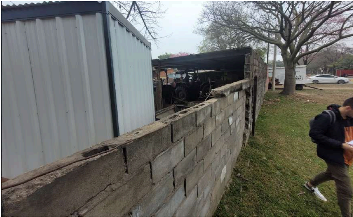
Imagen 3.4 - Paredón que separa Obrador Municipal con Plaza Castelli. Fuente: Producción propia.
