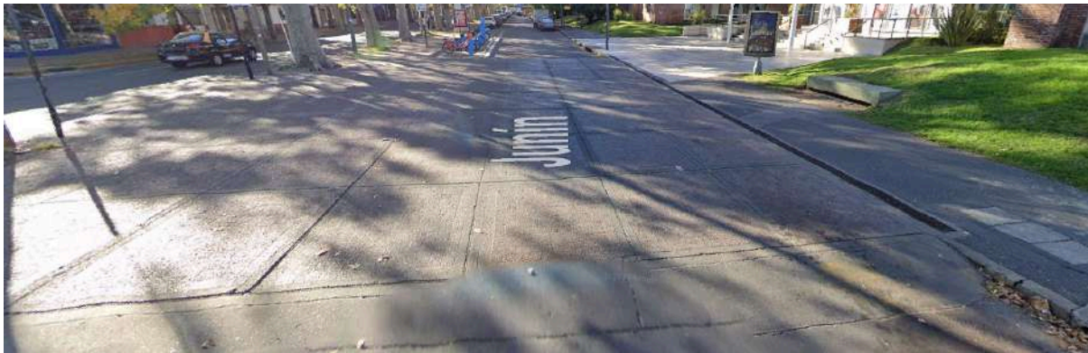
Imagen 6.4 - Ejemplo senda peatonal elevada en Calle Junin, Rosario, Argentina.
