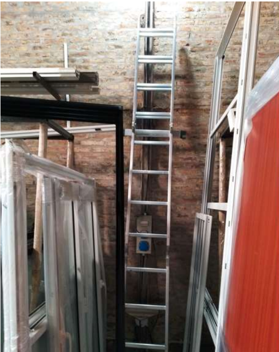
Fig. 79. Toma corriente obstruido
