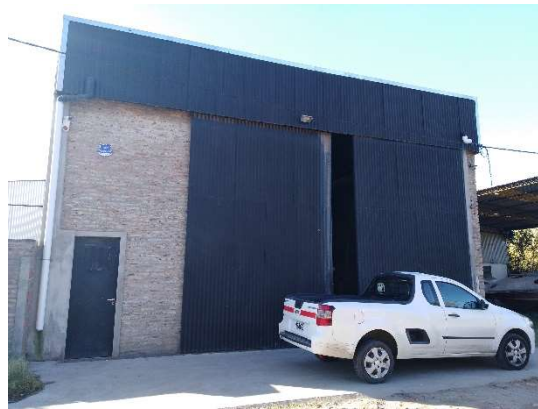
Fig. 91. Portón y puerta de acceso al taller
