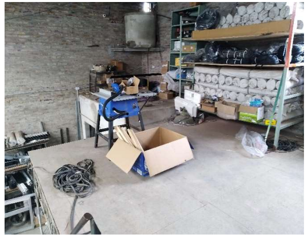
Fig. 37. Cajas y cables en el piso dificultando el paso
