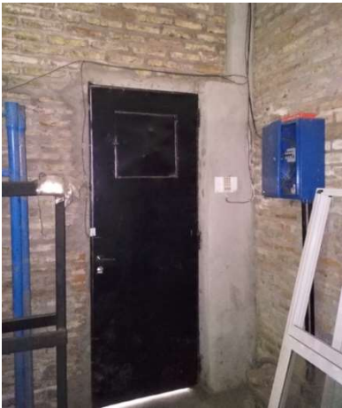
Fig. 71. Puerta de acceso al taller
