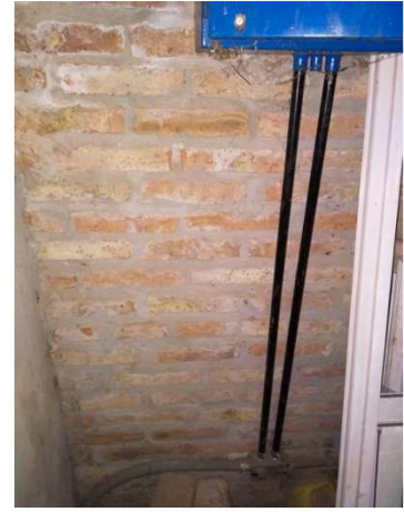
Fig. 73. Conductor conectado a tierra.
