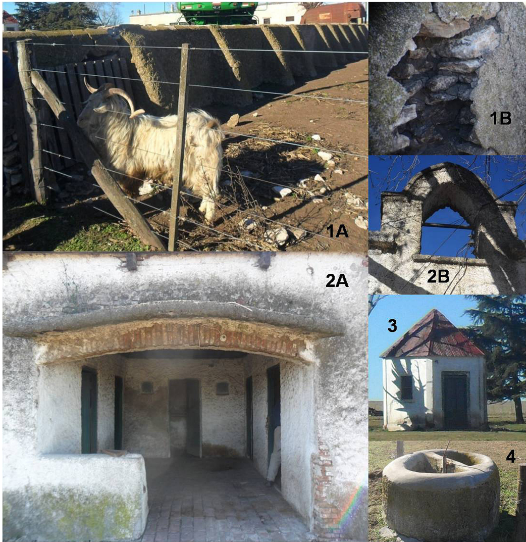
Figura 4. Imágenes correspondientes a las diferentes estructuras del sitio. 1A. Corral de piedra revocado donde se observan los contrafuertes. 1B. Detalle del revoque caído, se aprecia la construcción original de piedras lajas apiladas. 2A. Vista de uno de los laterales de la edificación. 2B. Espadaña de donde habría colgado la campana. 3. Recinto hexagonal que constituiría una antigua carnicería rural de principios del siglo XX. 4. Pozo de agua.
