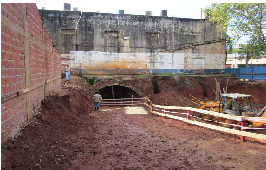
Figura 1. Estructura de Cisterna hallada en obra en construcción. Posadas. Misiones
