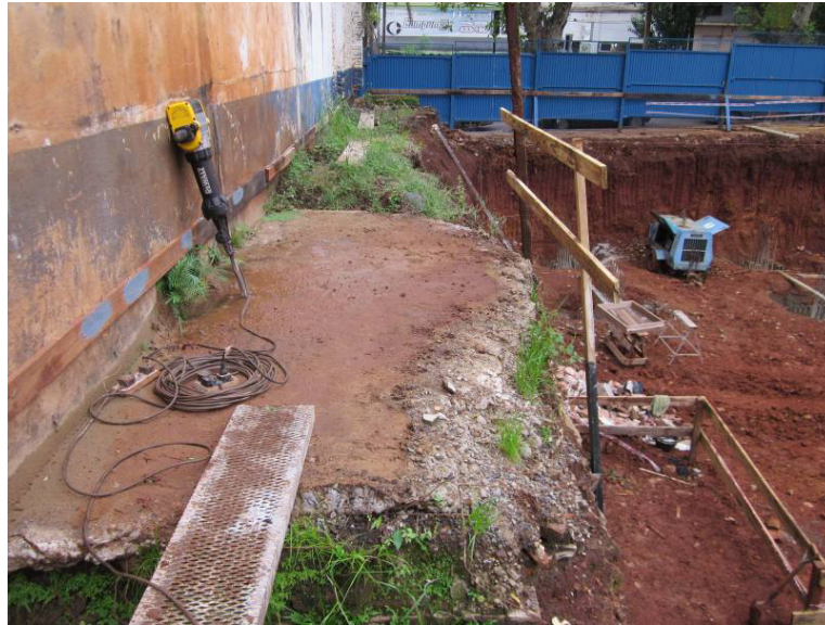
Figura 2. Sector Trinchera Piso sobre Cisterna. UE1
