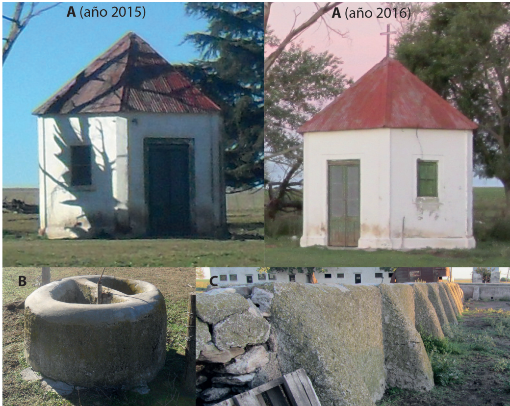
Figura 3. Estructuras anexas del sitio San Carlos. A) Antigua carnicería, hoy capilla. B) Pozo de agua. C) Corral con contrafuertes.
