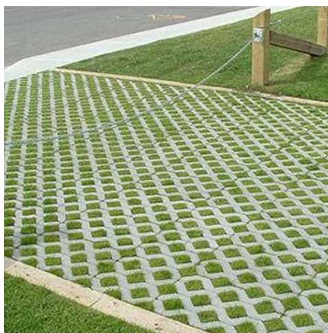
Ilustración 21: Tipología elegida de pavimento inter trabado.
