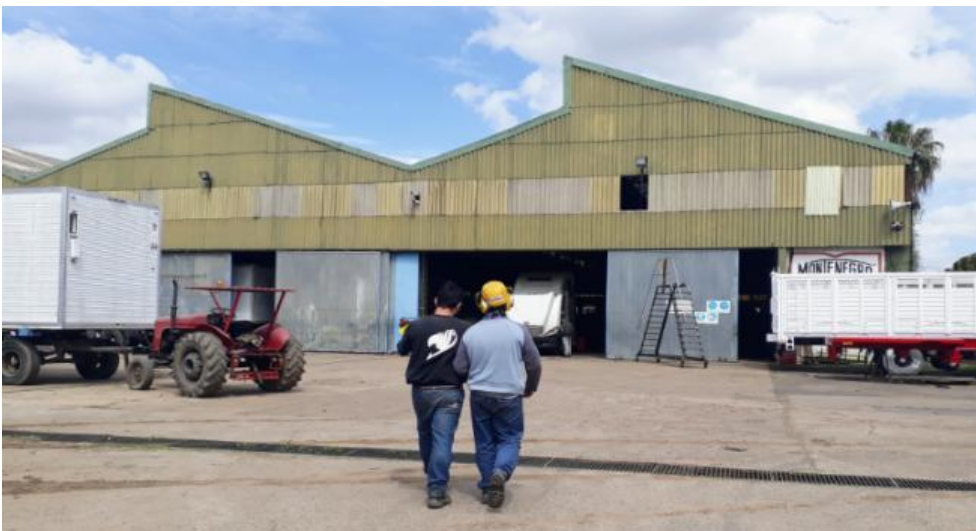
Imagen 6: Sector productivo (nave 1, 2 y 3)
