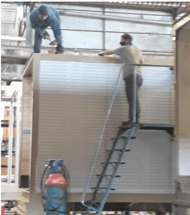
Imagen 54: Armado de la unidad
