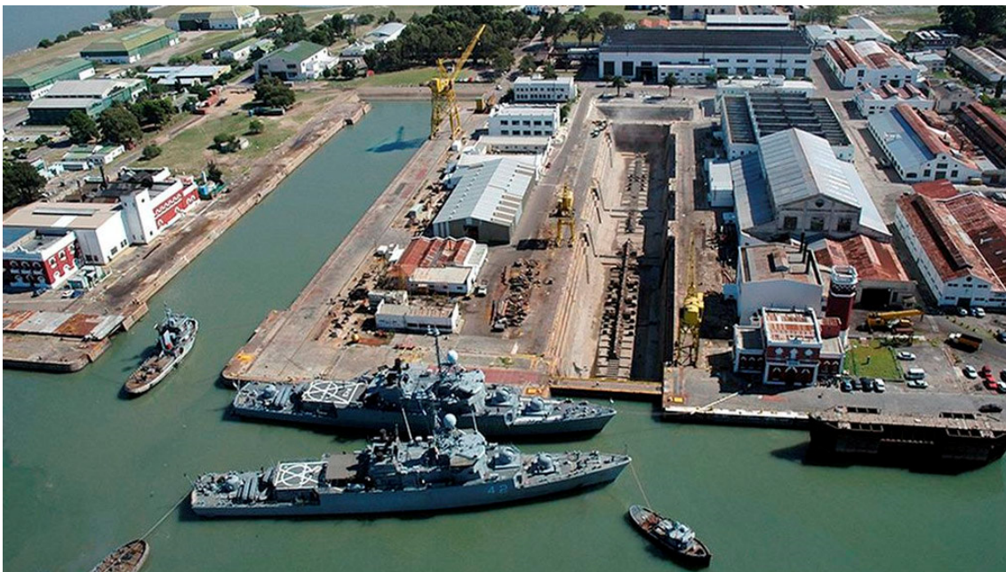
Figura 9 – Foto aérea Dique de Carena N°1 (derecha) y N°2 (izquierda)
