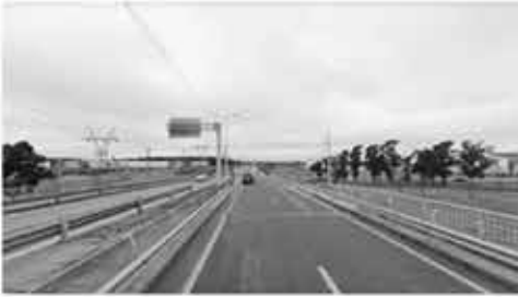
① Cruce elevado
