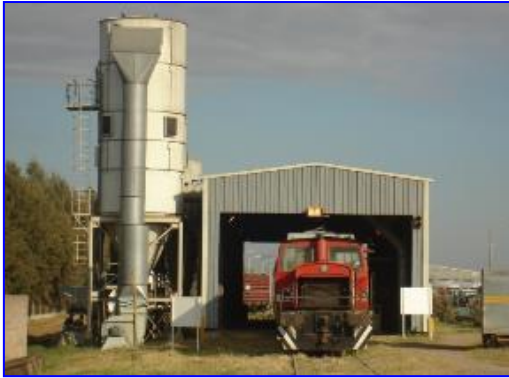
Figura 15. Filtro de manipuleo de cereal en descarga de vagones
