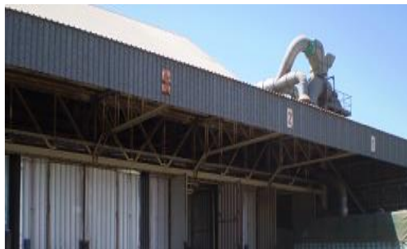
Figura 18. Aspiración lateral en descarga de camiones
