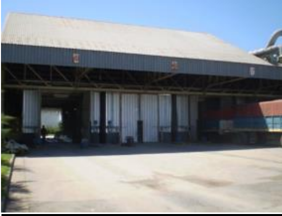
Figura 52. Descarga/carga de camiones cerradas para contener polvillo.
