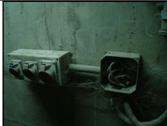
Figura 41. Caja de bornera sin tapa.
