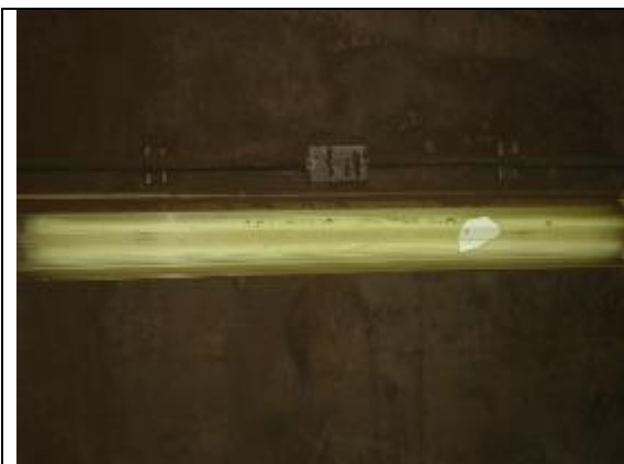
Figura 44. Artefacto de iluminación con plafón agujereado
