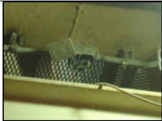
Figura 43. Caja de paso sin tapa.
