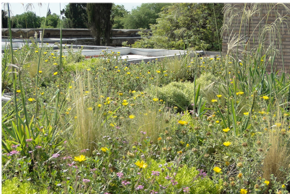
Figura 5.1 Vista general del ensayo de cubierta vegetada en el Aula Taller de la Facultad de Arquitectura de la Universidad para analizar atributos de biodiversidad.
