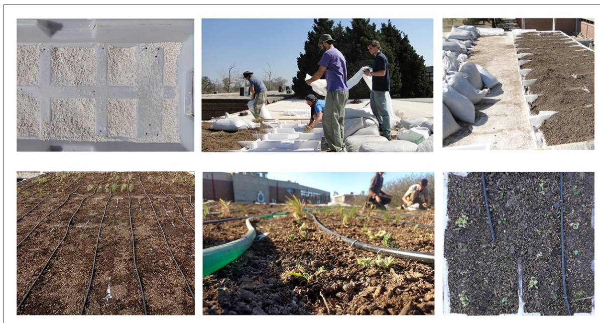
Figura 4.2 Construcción de CVE a escala real de techo para la evaluación de atributos de biodiversidad. Facultad de Arquitectura-UCC. Fecha: septiembre 2018.
