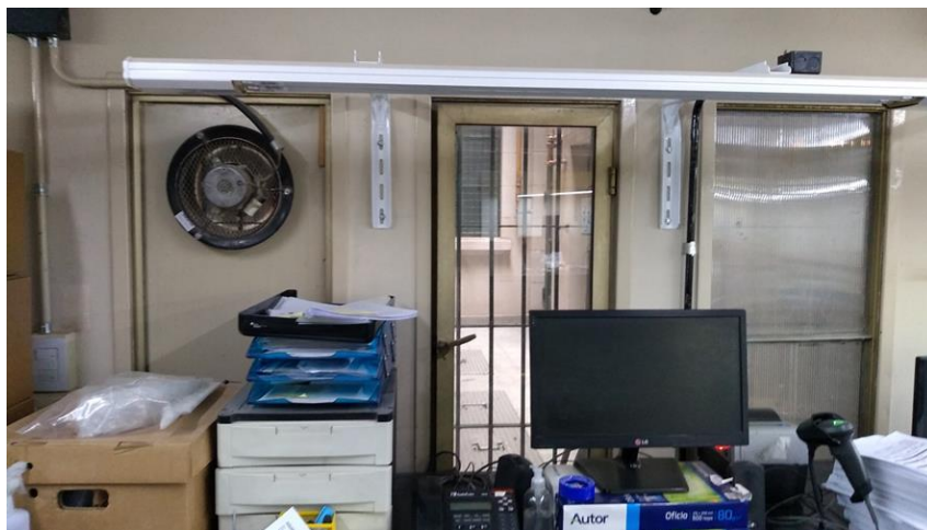
Foto 3, ventiladores alojados en patio interno induciendo la ventilación forzada.
