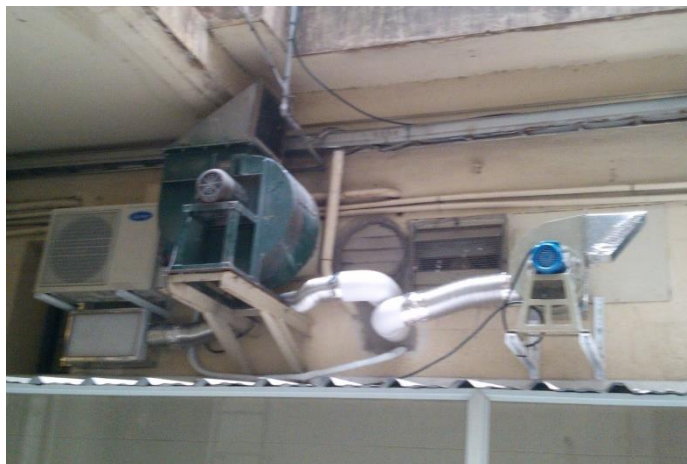
Foto 3, ventiladores alojados en patio interno induciendo la ventilación forzada.
