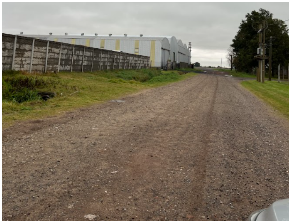
Figura A.8.2. Tramo 1. Fuente: elaboración propia.
