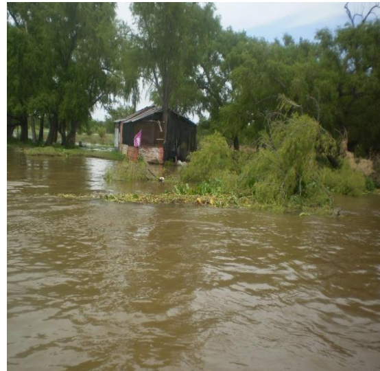
Vivienda toda de chapa.
