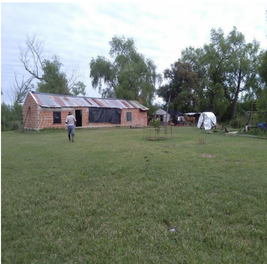
Vivienda de material y techo de chapa.
