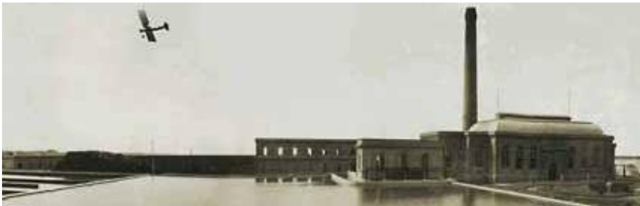
Imagen de la primer planta potabilizadora de agua de Rosario
