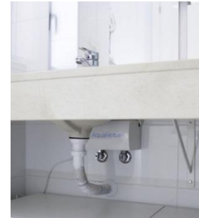
Ejemplo de instalación de sistema Aquareturn
