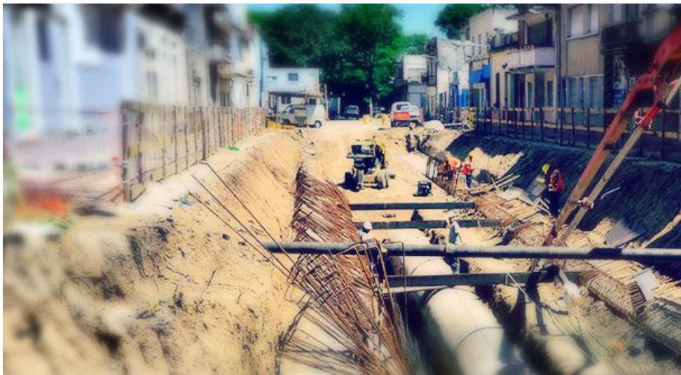
Obras de Saneamiento
