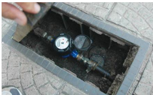
Llave de corte, ubicación y funcionamiento
