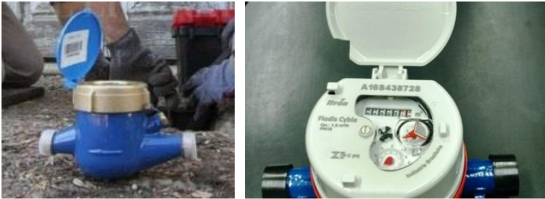
Medidor de agua
