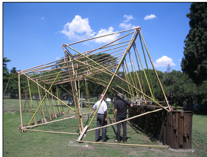
Construcción del invernáculo
