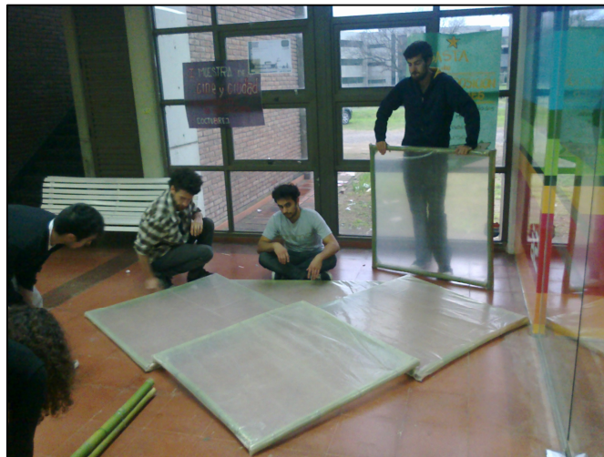
Estudiantes de arquitectura durante la construcción del invernáculo
