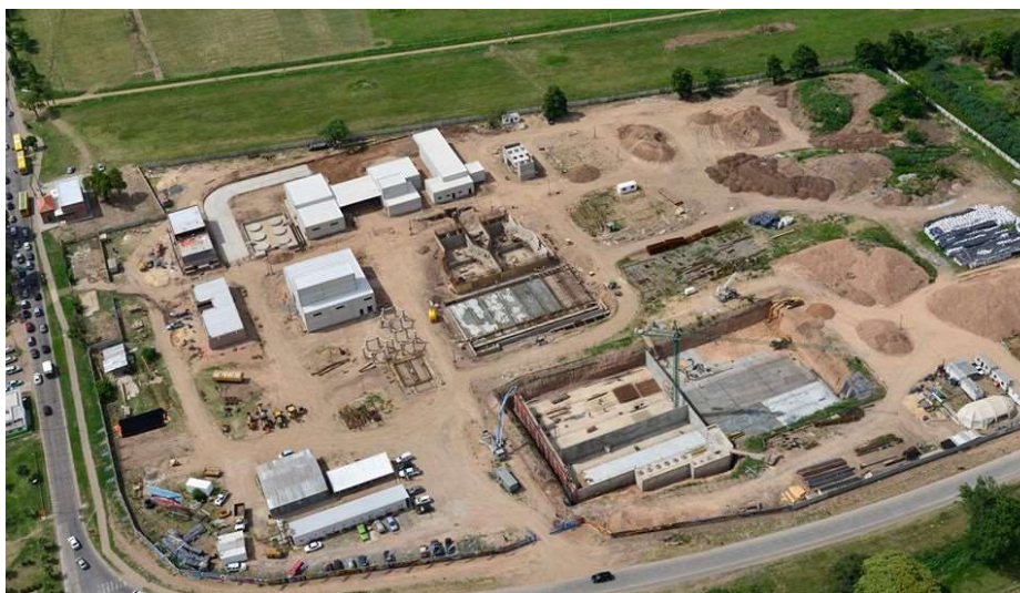
Imagen 10.1 – Obras de planta de tratamiento de agua tratada convencional en Granadero Baigorria. Acueducto Gran Rosario, etapa 1.
