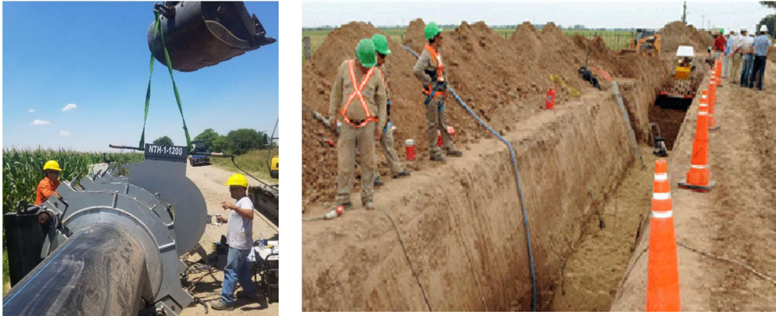
Imágenes 10.2 y 10.3 – Instalación de cañerías de agua tratada. Acueducto Desvío Arijón, etapa 2.
