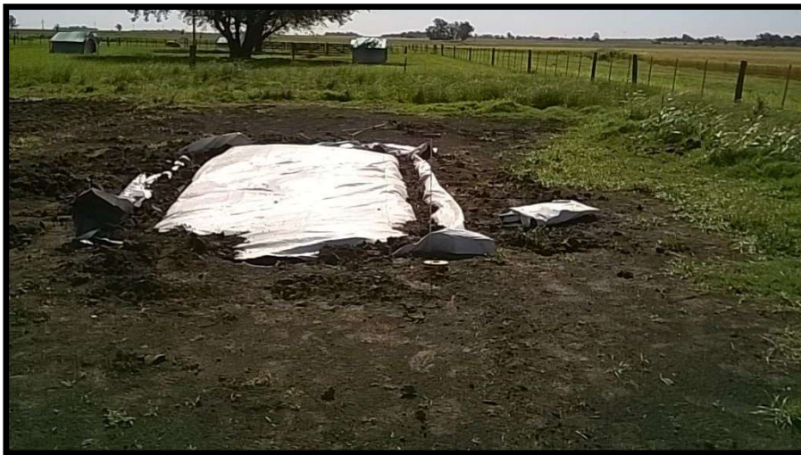
Foto 4: Impermeabilización del área de compostaje
