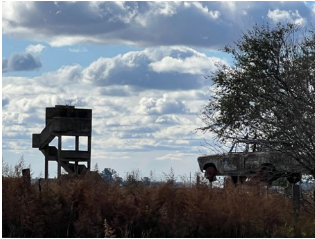
Figura 170. Torre de transmisión abandonada en el ex-predio Paraíso Tuerca, pre-existencia que determina un sitio estratégico para la construcción del artefacto de paisaje Museo Extendido . Fotografía de la autora (2024).
