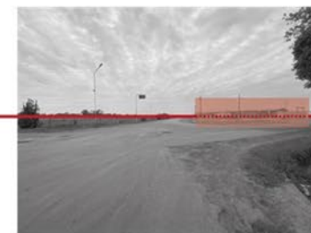
Ex-depósito de maquinaria y herramientas de la Comuna de Elortondo, ya trasladado, hoy en proceso de demolición y limpieza SITIO DE OPORTUNIDAD
