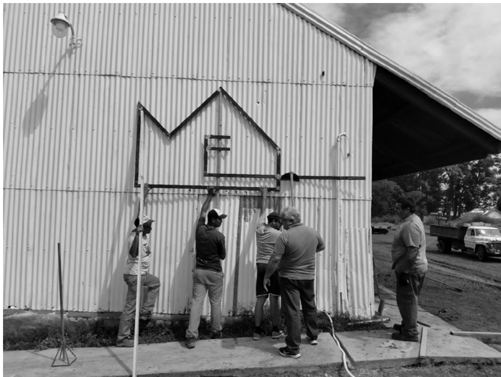
Figura 74a. Museo Elortondo. Proceso de obra. Fotografía Arq. Marcelo Scazzina (2023).
