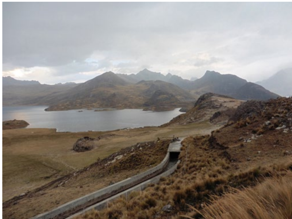
Figura 3. Uno de los canales del proyecto Marca III que forma parte del sistema de transvase de agua Rímac-Mantaro. Foto tomada por L. Hommes, 2015.
