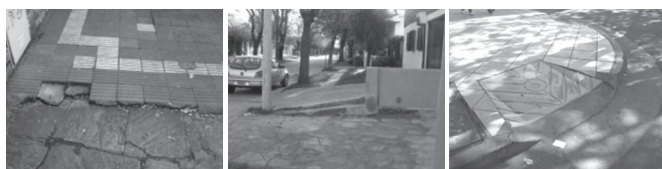
Barreras urbanas detectadas luego de las entrevistas con usuarios y taller vivencial como veredas en mal estado, con cambio brusco de nivel y rampas de esquina deterioradas.
