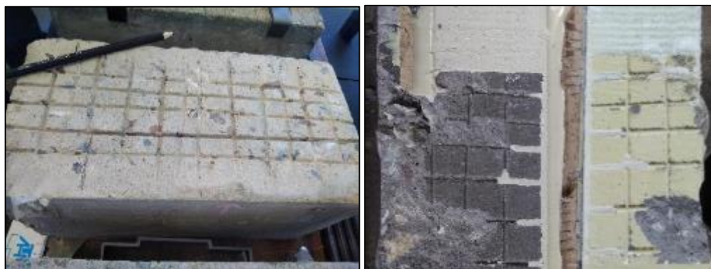
Figura 6.17 – Ranurado de la superficie H° y modo de falla
