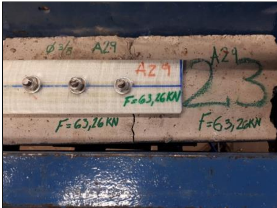
Figura 5.48 - Tipología de falla - Rotura del H° en correspondencia 3° bulón - Probeta A29.
