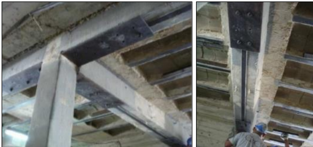
Figura 2.66 - Otros sistemas de anclajes extremos abulonados
