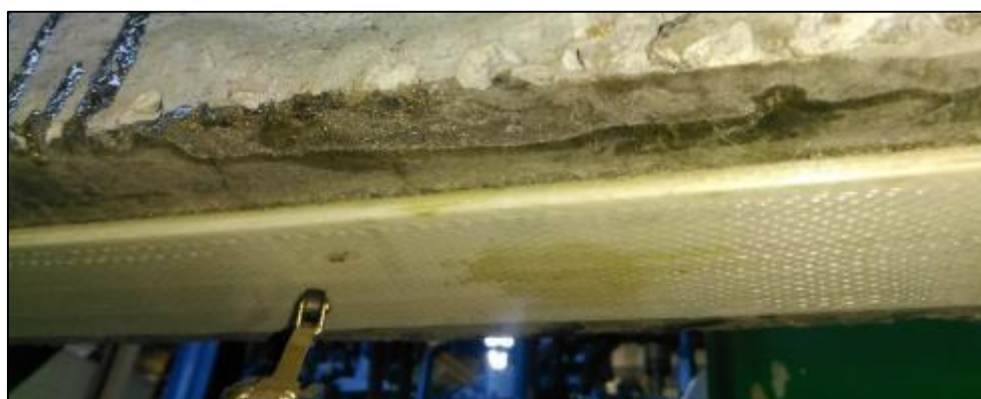
Figura 4.27 - Vista inferior de la viga V3.
