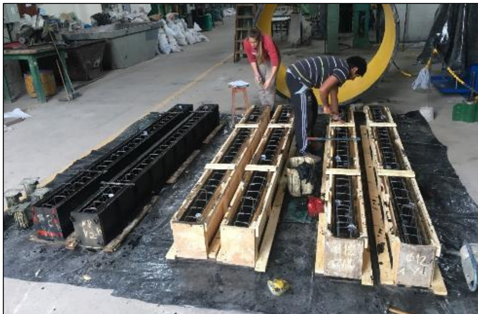
Figura 4.12 - Preparación de las vigas.
