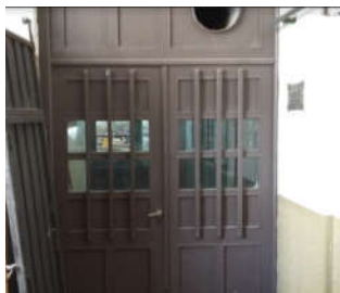
Figura 15: Ingreso principal taller de carpintería Fuente:Elaboración Propia
