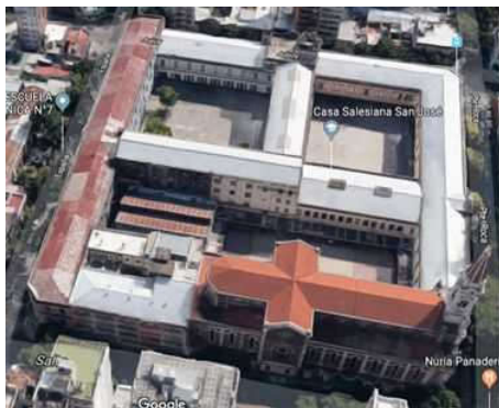
Figura 3: Imagen aérea del Establecimiento
