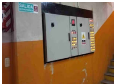
Figura 35: Tablero principal taller máq herramienta Fuente:Elaboración Propia
