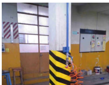
Figura 48: Salida de emergencia taller de máquinas herramienta a patio externo Fuente:Elaboración Propia
