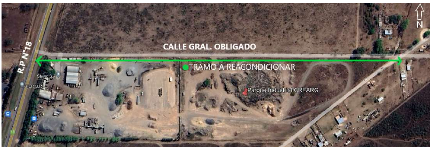
Figura 3.3.1. Tramo a reacondicionar de la calle Gral. Obligado
