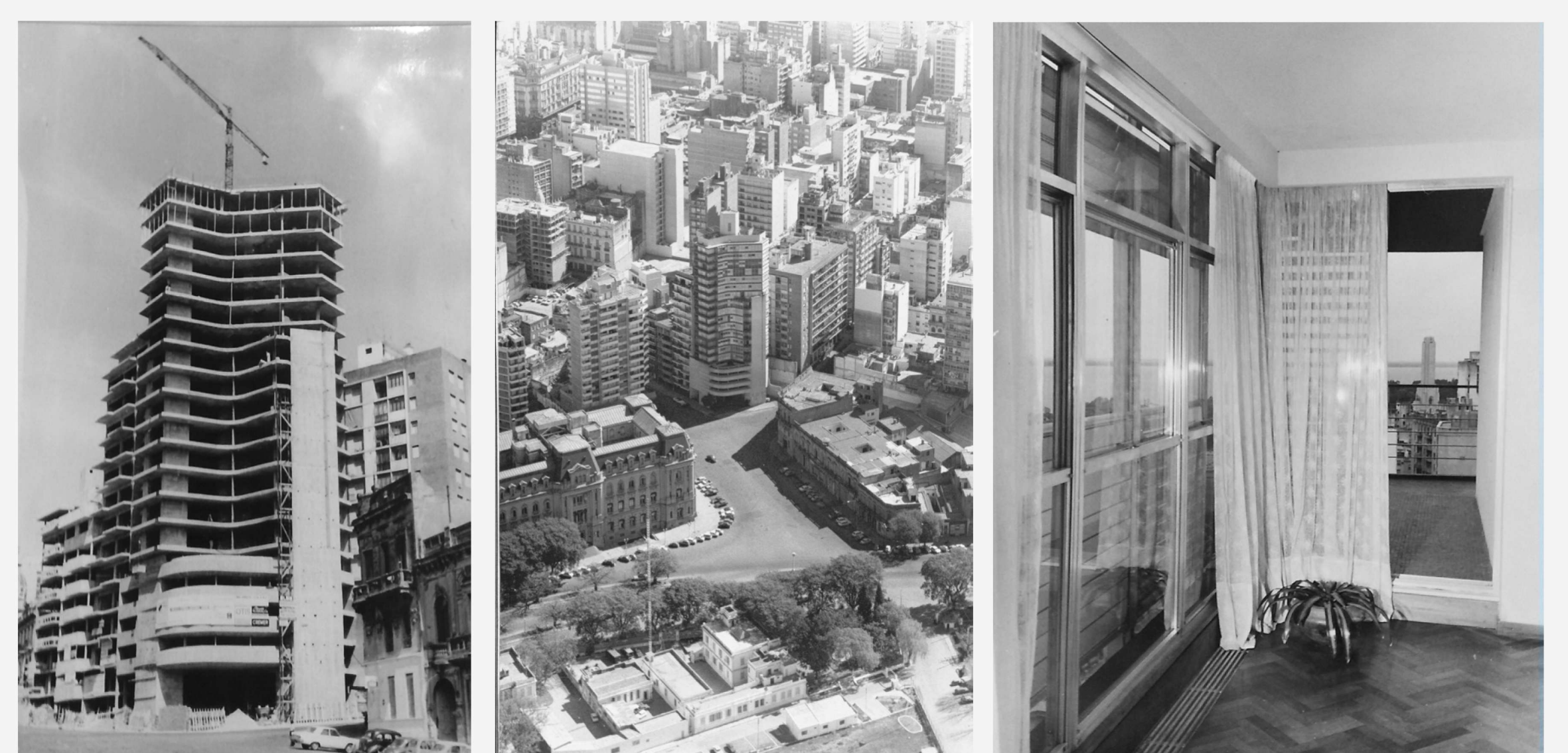
Edificio Farallón. Fotografía del edificio al momento de su construcción y finalizado. Fotografía desde el interior del edificio. Archivo Spirandelli y Asociados.
