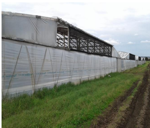
Foto 1. Exterior de invernáculos
