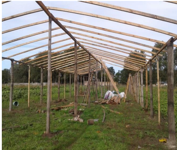
Foto 19. Invernáculo en construcción (proyecto de agricultor de SAAC 2)
