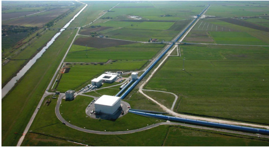
Figura 2.10: Foto aérea del interferómetro Virgo, se observan el edificio central, el edificio del Mode-Cleaner, los 3 km totales del brazo oeste y parte del principio del brazo norte (a la derecha). Los demás edificios son zonas de trabajo varias y la sala de control. Fuente https://www.ligo.caltech.edu
