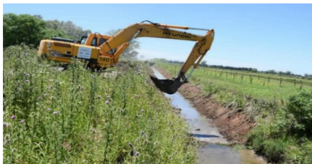
Figura 18. Reacondicionamiento de Canal Salvat
