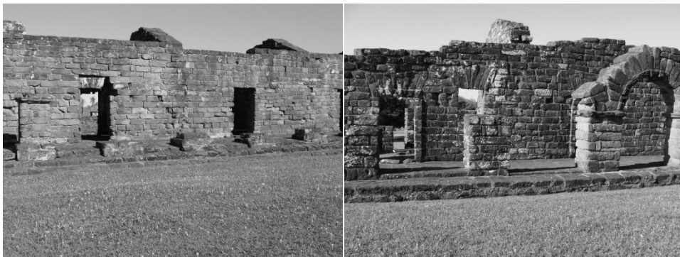
Figura 2: Dinteles de una o dos rocas en Santísima Trinidad. Figura 3: Dinteles en cuña en Santísima Trinidad
