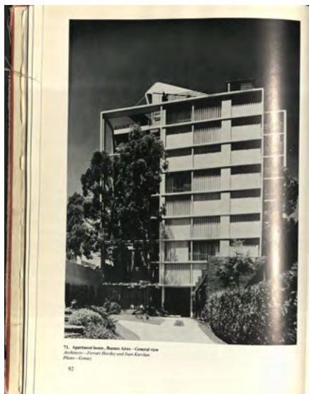
Edificio Los Eucaliptos y Edificio Ateliers. Fuente: Architect's years book 3 . London: Paul Elek, 1949. p. 92 y 94.
