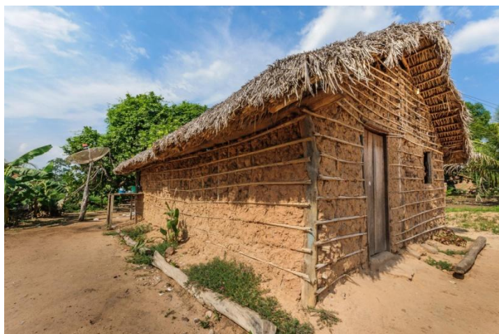
Figura 1. Casa de pau a pique o casa de taipa
