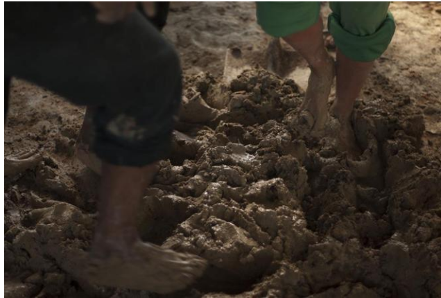
Figura 5. El proceso de pisotear el barro para la construcción de casas
