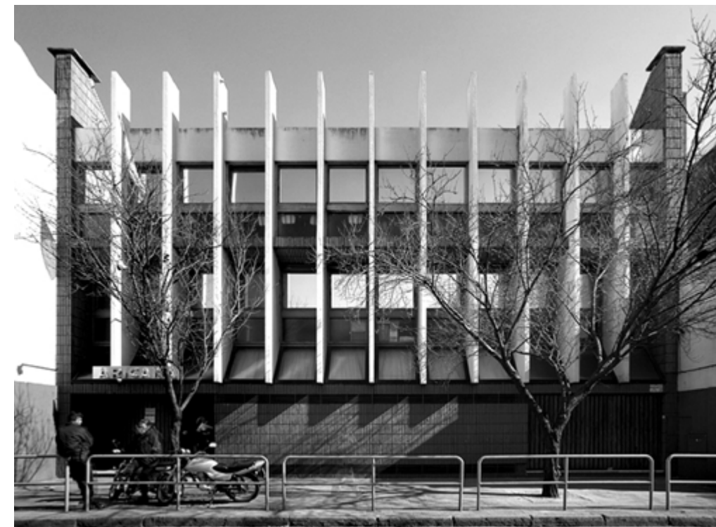
ARICANA. Fachada. Hernández Largaía, de la Torre, Moliné y Santanera
