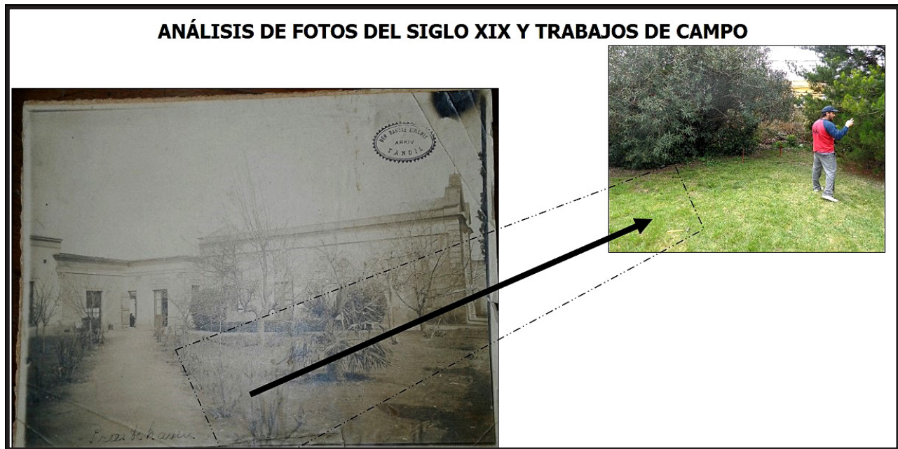
Figura 5. Análisis de fotos antiguas y trabajos de campo preliminares; donde se toma la posición en donde se colocó el fotógrafo y sacó la foto, para sondear el subsuelo para comprobar si se preserva el piso de roca.
